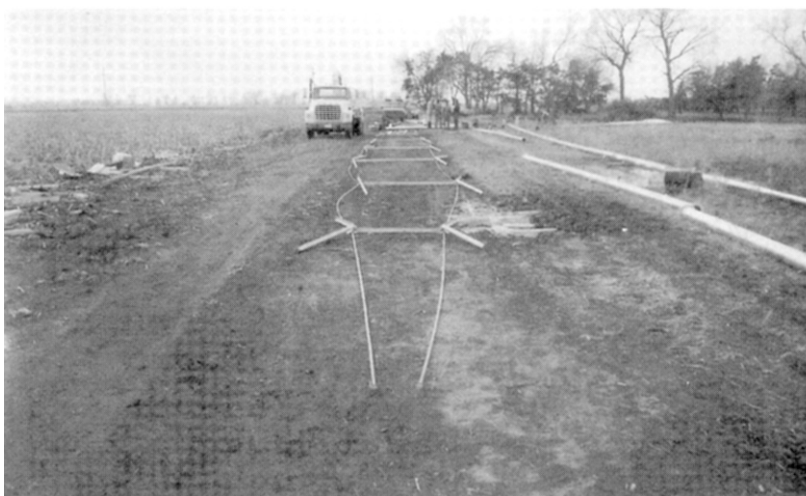
NESTA FOTOGRAFIA O ESQUELETO DA TRELIÇA ESTÁ MONTADO SEM O TUBO.
